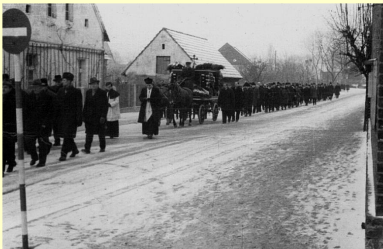
Taki kondukt pogrzebowy przechodził ulicami Groszowic jeszcze na początku lat 70-tych ubiegłego wieku
